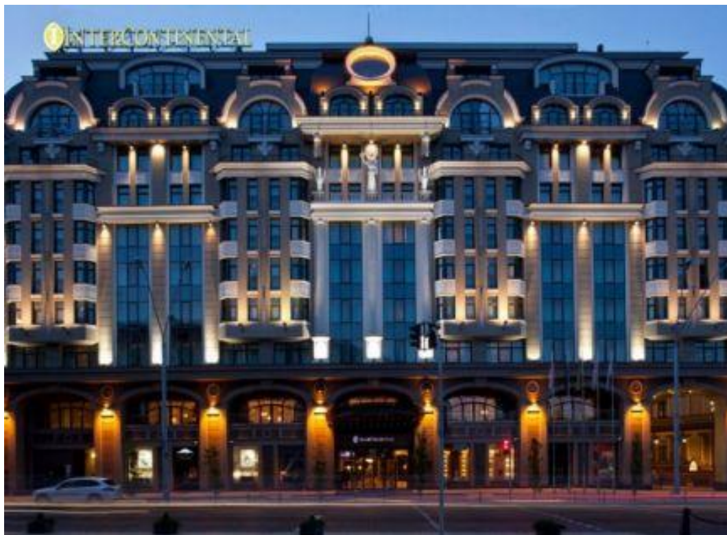
Рис.1.1 Фасад готельно-ресторанного комплексу ІнтерКонтиненталь Київ
