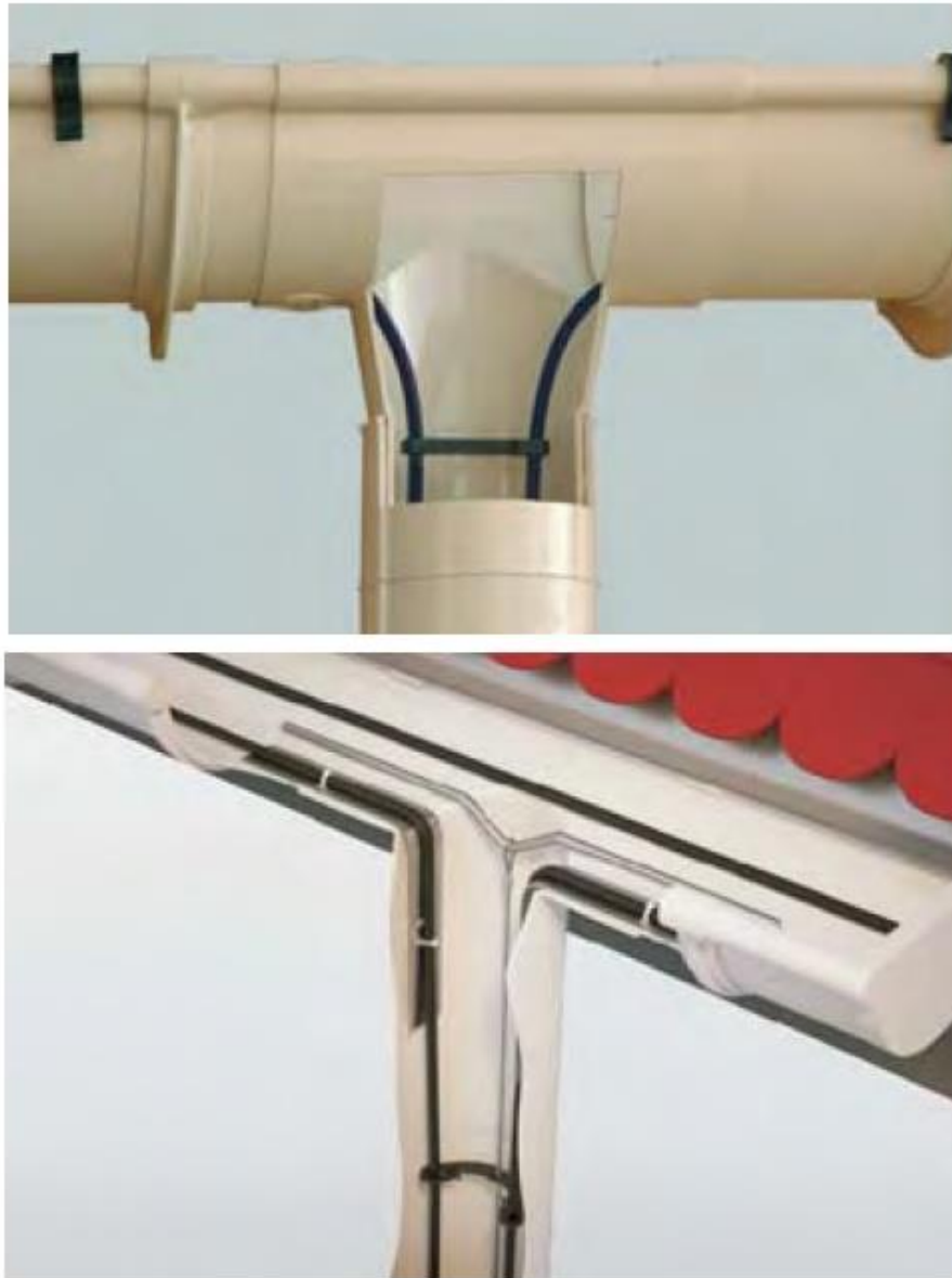
Рис. 2.10 Засоби захисту дахів і водостоків від зледеніння.
