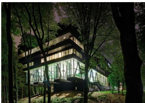
Рис. 2.9. Rehabilitation Centre Groot Klimmendaal [27].
