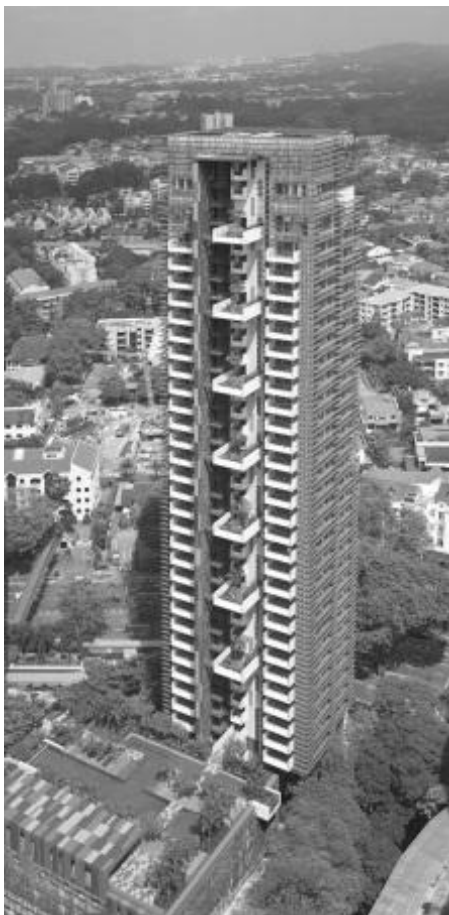
Рис. 6 Жилой дом Ньютон Суитс, Сингапур
