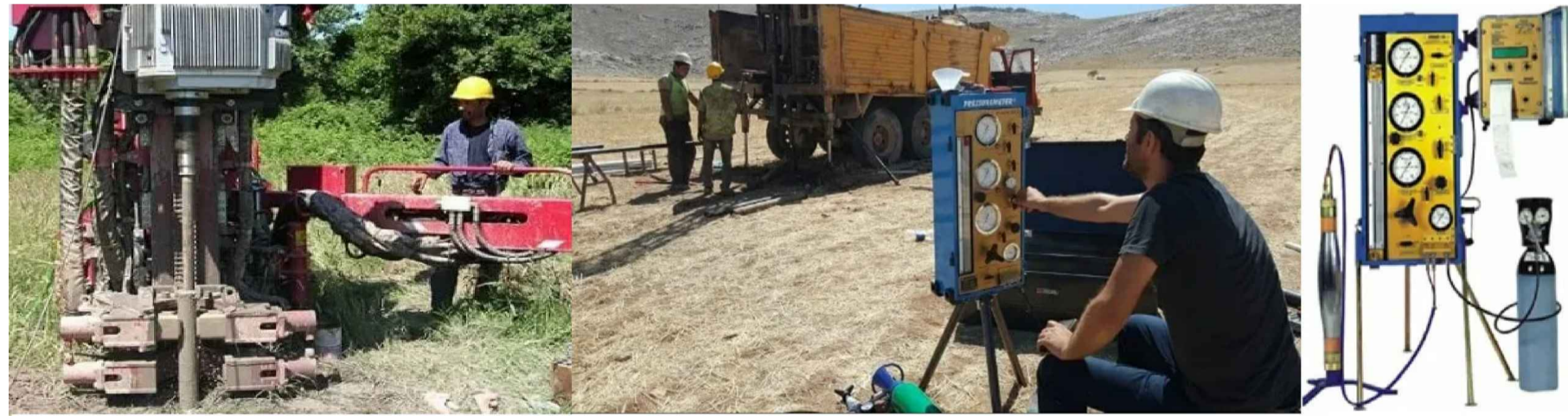
Проведення випробувань ґрунту пресіометром на будівельному майданчику
