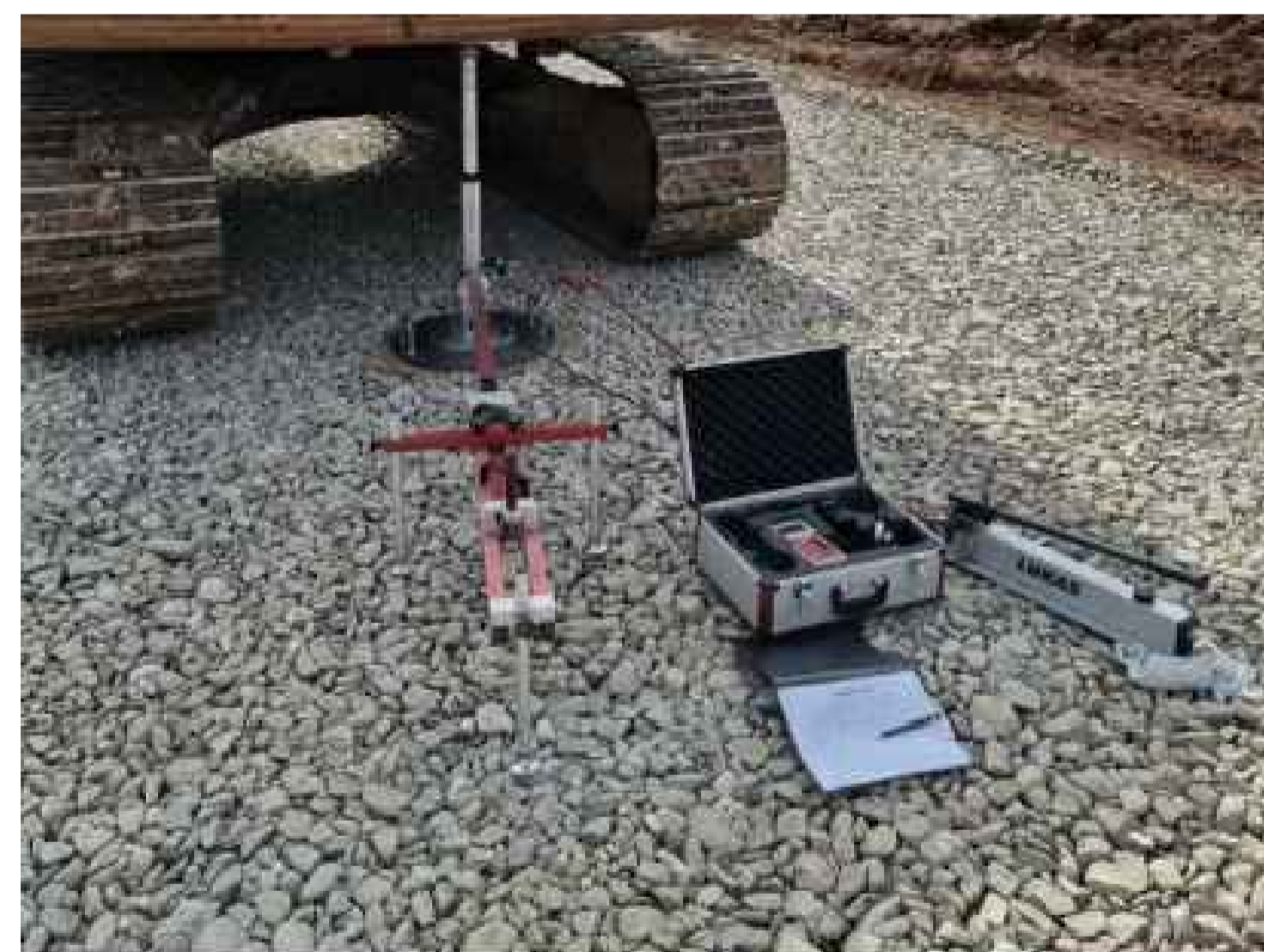
Проведення штампових випробувань ґрунту установкою статичного гавантаження "HMP PDG"
