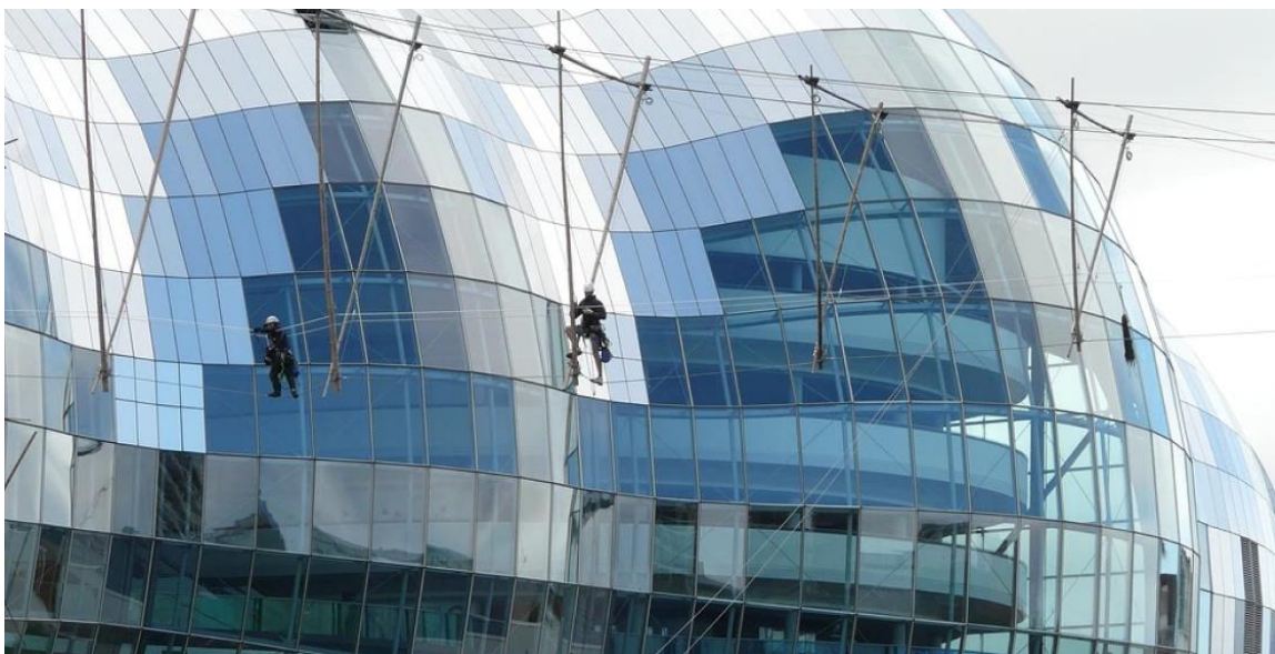
Рис. 6.3 Навісний фасад в екстер'єрі будівлі
