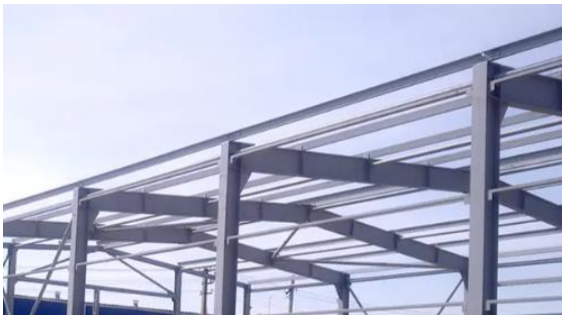
Рис. 6.1 Двотаврові металеві колони в конструктивній схемі
