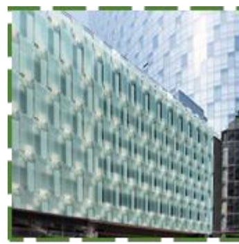
Рис.2.3.4 Приклад скляного вентилязованого фасаду
