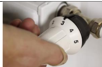
Терморегулюючий клапан для бокового підключення
