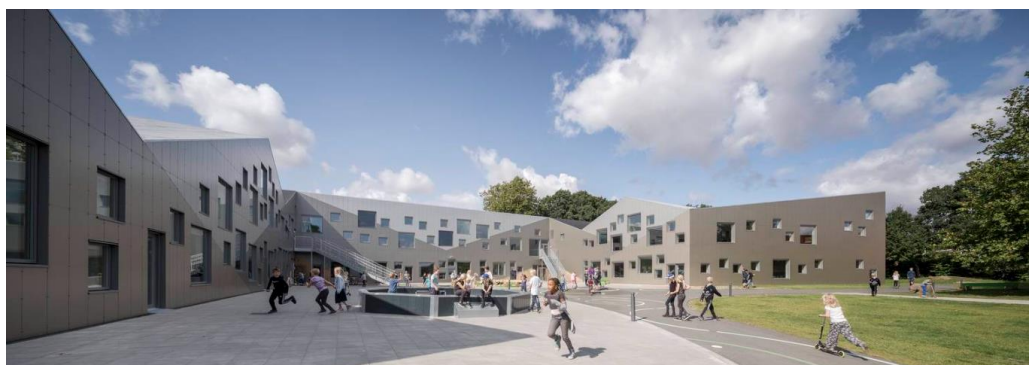
Рис.2.22 Фасад школи з композитних ахроматичних панелей [30]
