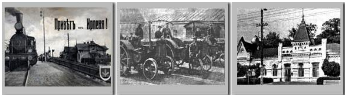
Рис. 3.1.1 Фотофіксація будівництва залізниці [35]
