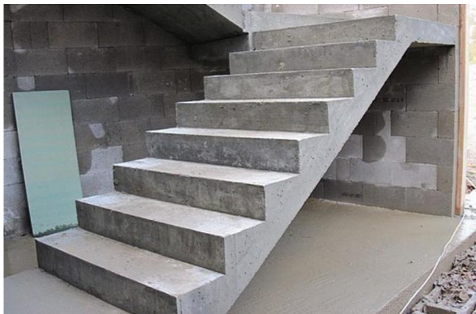
Рис. 6.1.6 Зображення монолітних бетонних сходів [39]
