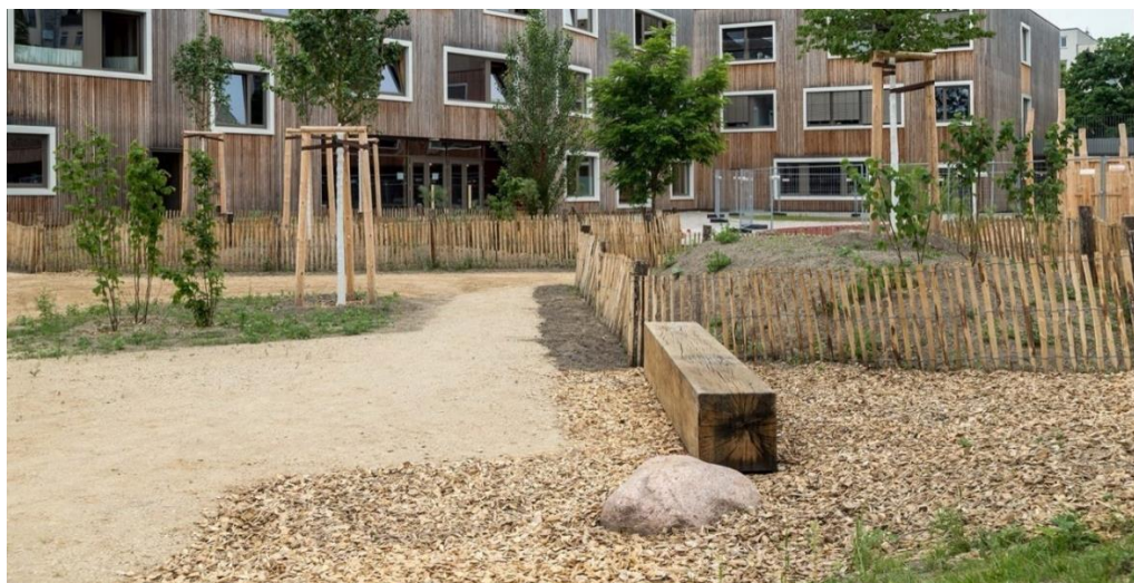
Рис. 2.12 Використання водопроникного мощення на ділянці кампусу (2.12) [28]
