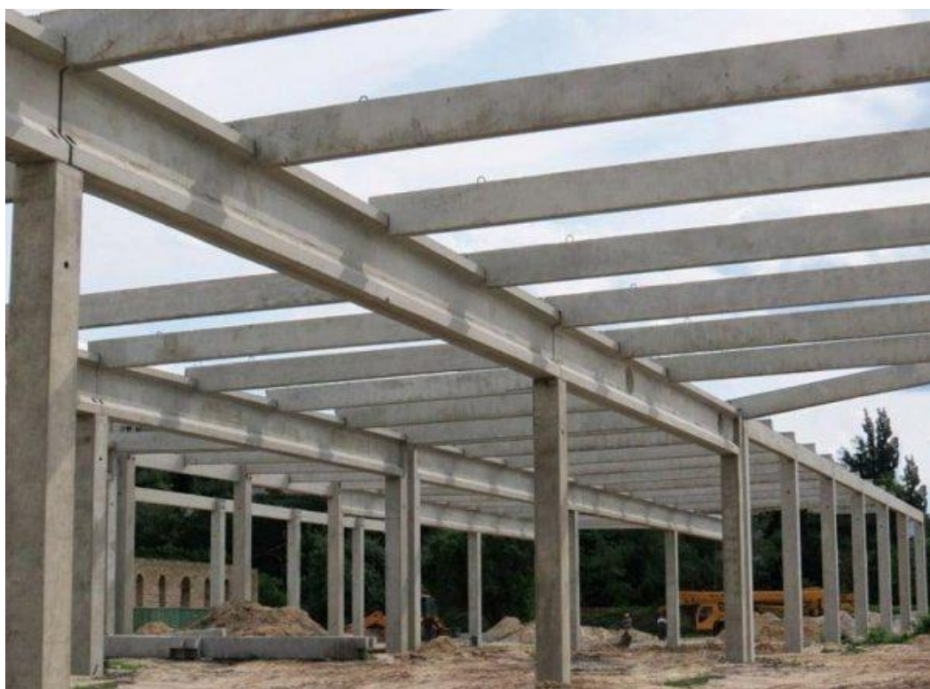
Рис.6.1.1 Зображення залізобетонного каркасу з колонами
