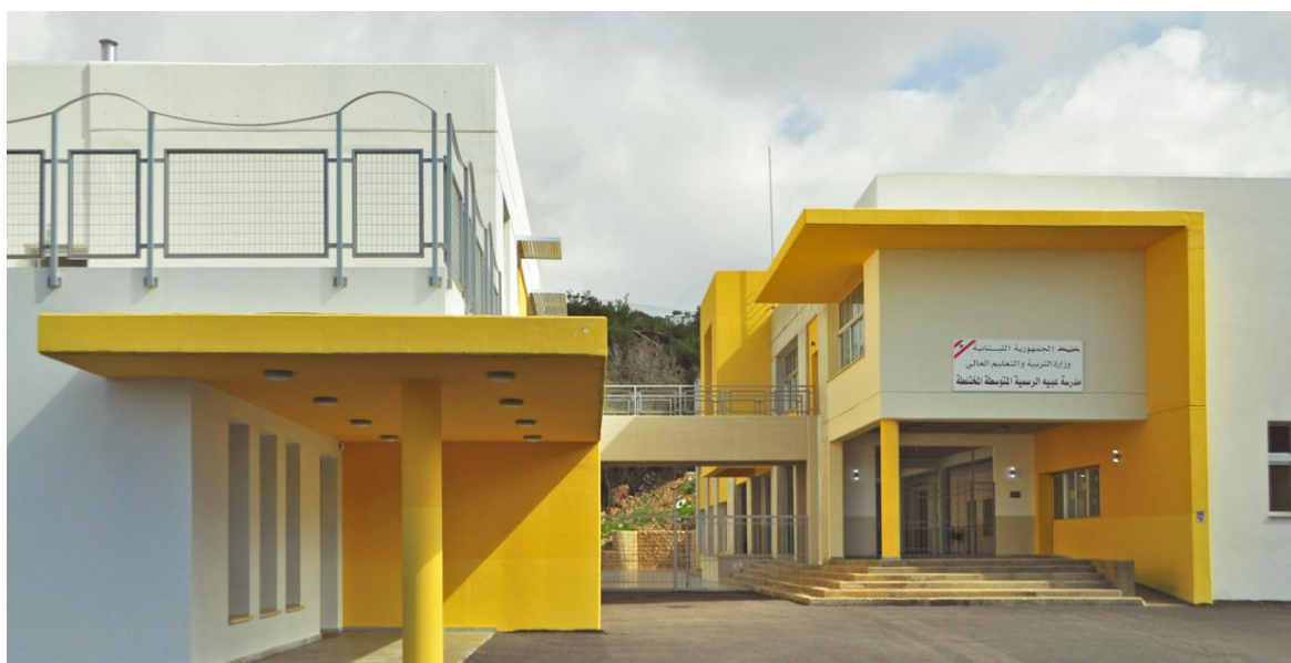
Рис.2.30 Внутрішній двір школи Abey [32]
