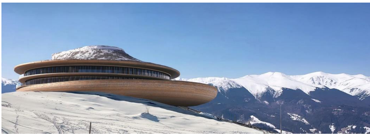
Рис. 2.6. Загальний вигляд будівлі готелю «Карпати» [3]
