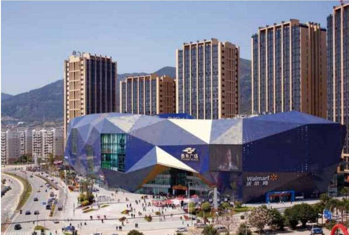
Рис. 2.3.3. торговий центр Фучжоу, Китай. Арх. бюро Spark,
