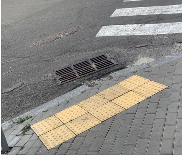
Рис. 1.2., 1.3. Приклад неправильного розміщення тактильної плитки перед пішохідним переходом
