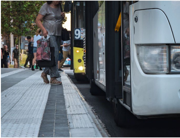
Рис. 1.20., 1.21., 1.22., 1.23. Неправильний підїзд громадського транспорту після встановлення касельського бордюру у м.Львів.
