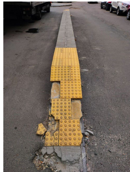
Рис. 1.4, 1.5. Приклад неправильного використання тактильної плитки
