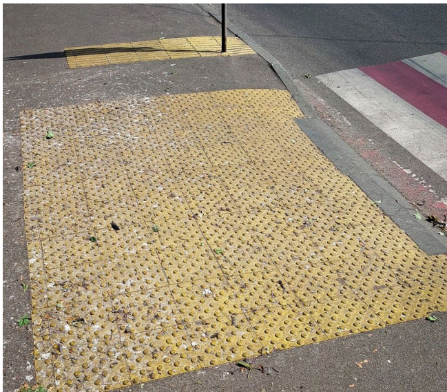
Рис. 1.4, 1.5. Приклад неправильного використання тактильної плитки
