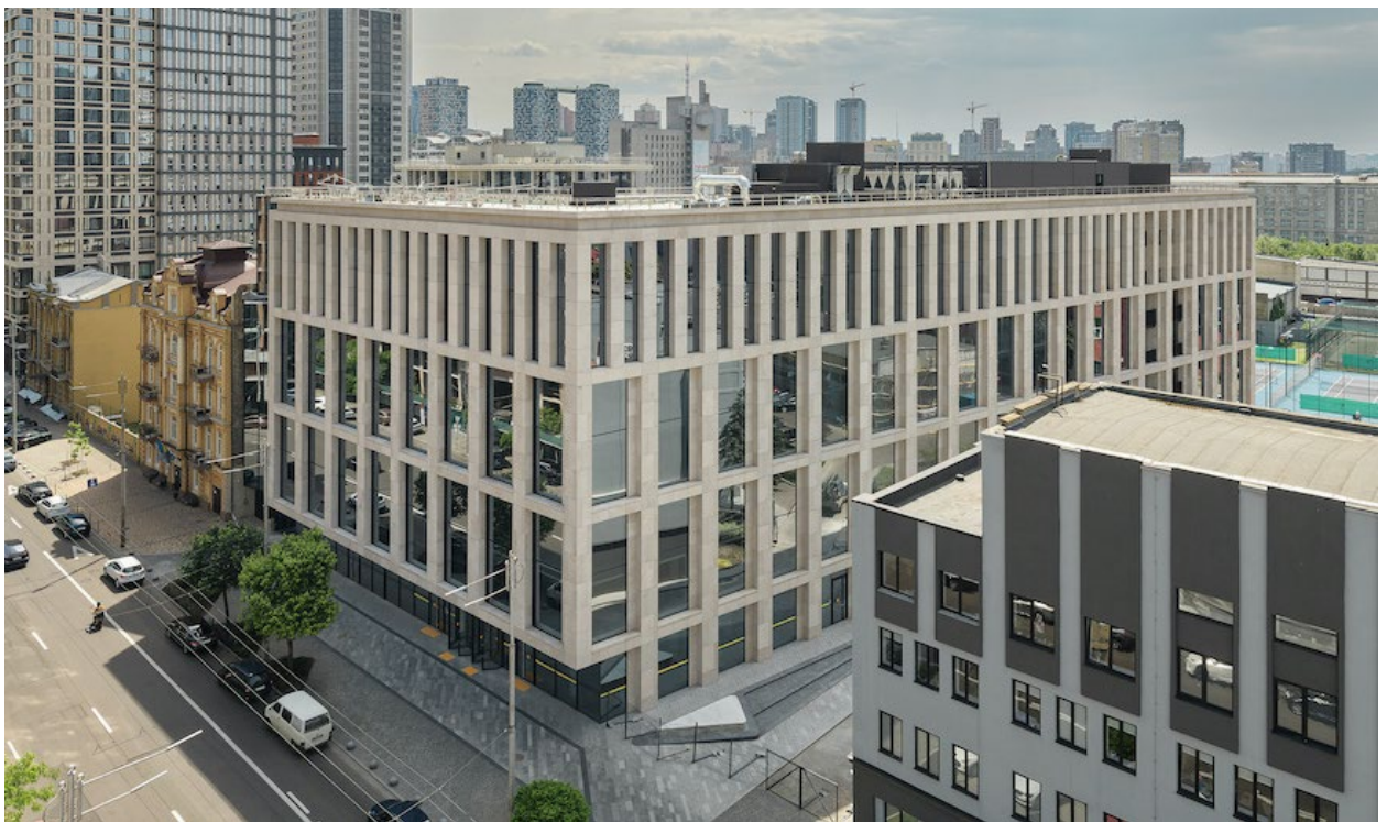
Рис. 2.31. Вигляд будівлі після реконструкції
