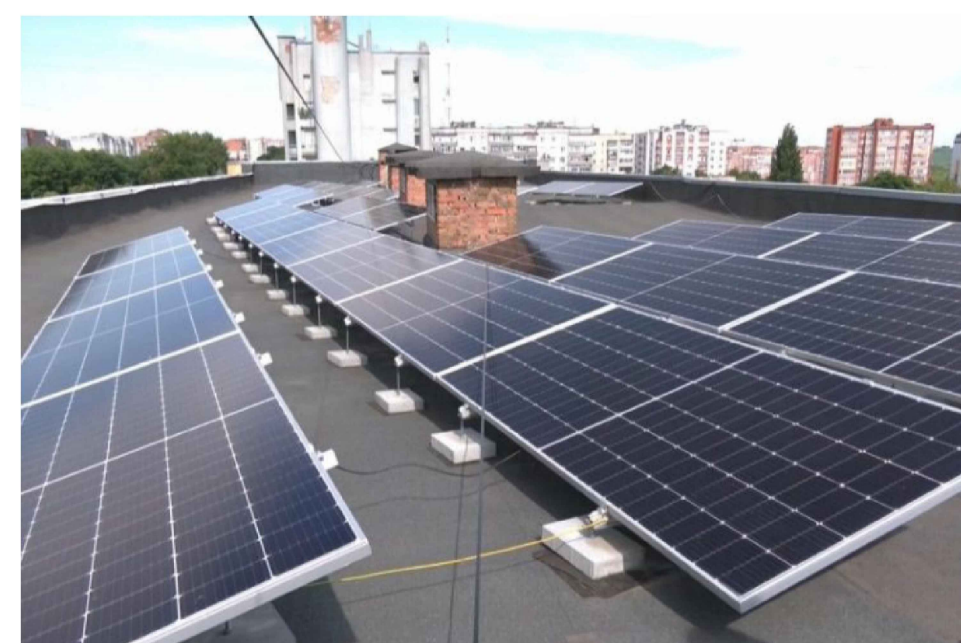
Рис. Сонячні фотоелектричні модулі на дахах будинку
