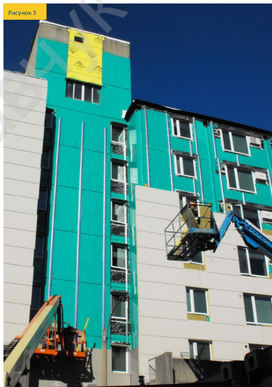
Рис.9. Оздоблювальні роботи фасаду
