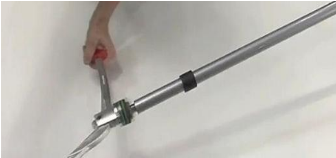
Мал. 2.7.3.2. Процес розширення труби для подальшого монтажу
