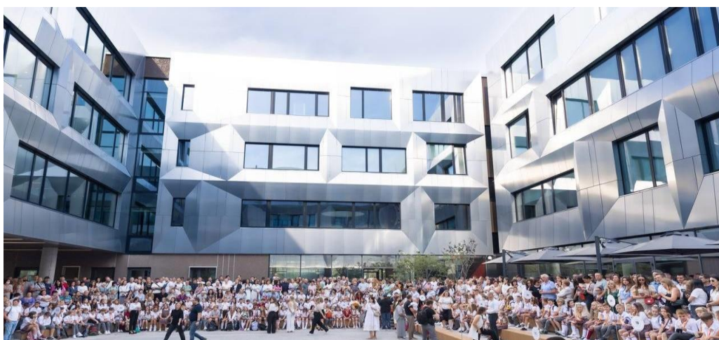
Рис. 1.3.8. Приклад оздоблення фасадів енергозберігаючими панелями колегіуму, м. Київ, 2017 р. [37]
