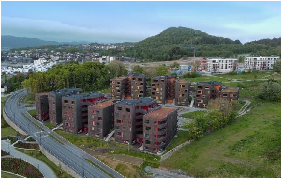
Рис. 2.4.1. Загальний вигляд комплексу [4]
