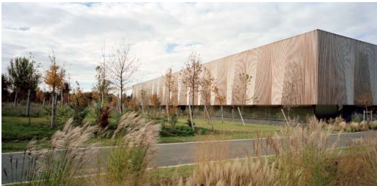
Рис. 2.11. Архітектурний образ будівлі [7]
