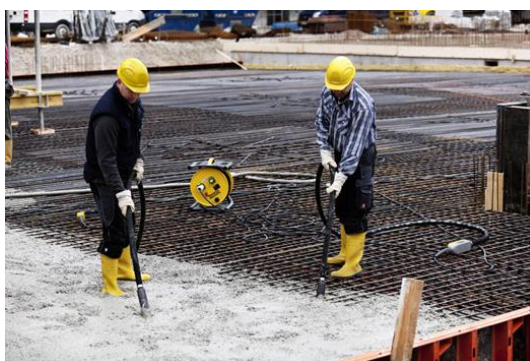
Рис. 4.3 Будівельник вібрує бетонну суміш за допомогою глибинного вібратору
