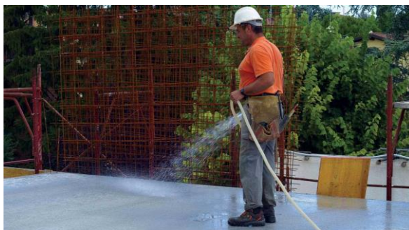
Рис. 4.4 Будівельник зволожує бетонну плиту після укладання розчину
