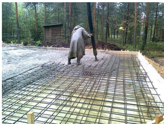
Рис. 4.2 Будівельник укладає бетонну суміш за допомогою бетононасосу
