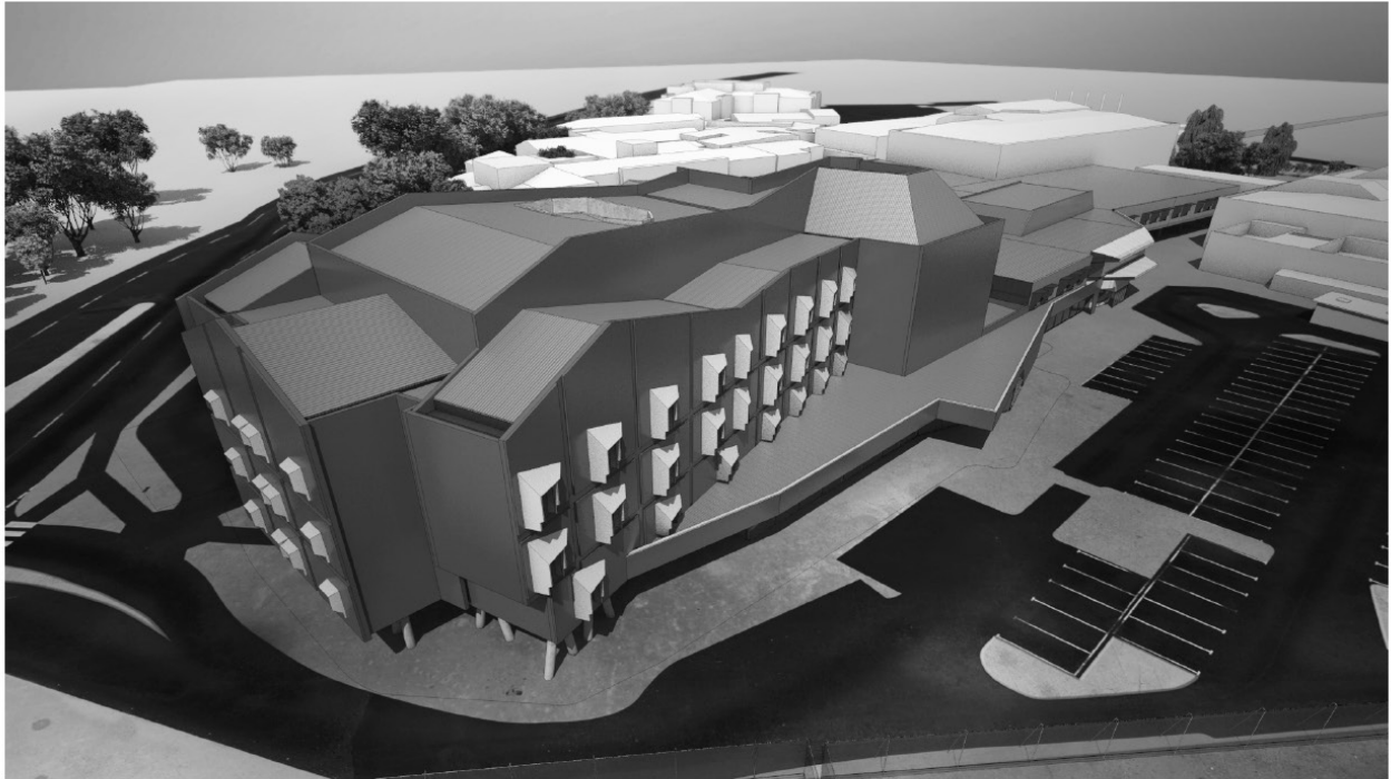
Рис. 6. Лікарня невідкладної медицини Frankston Hospital Stage 3 and Emergency Department Frankston, Australia
