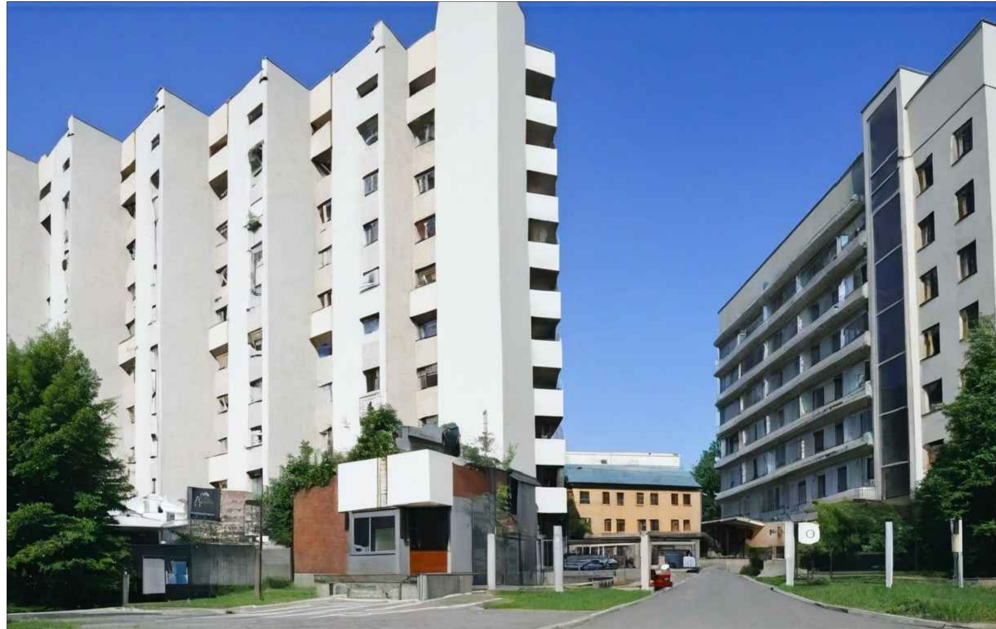
Фотофіксація об'єкта реконструкції
