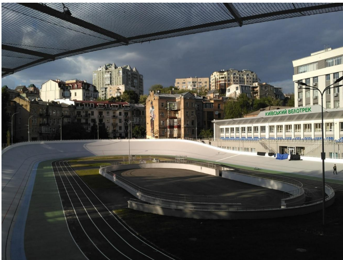
Рис. 2.31. Загальний вид Київського велотреку [41]
