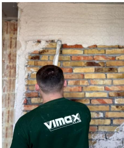
Рис. 1. Процес нанесення вапняної штукатурки механізованим способом
