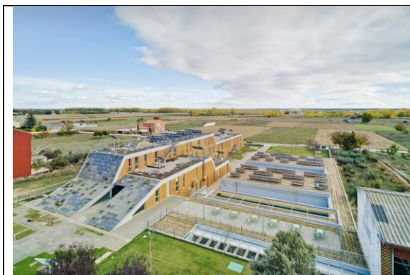
Рис. 1.13. Загальний вигляд будівлі з висоти пташиного польоту [19]
