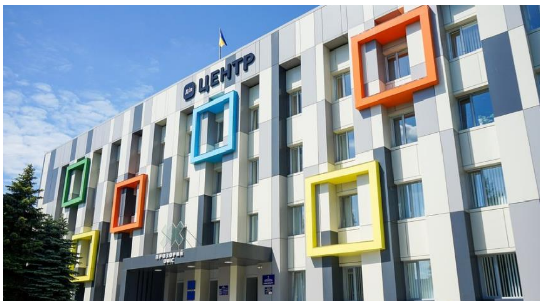
Рис. 2.10.1. Загальний вигляд будівлі Дія Центру [16]
