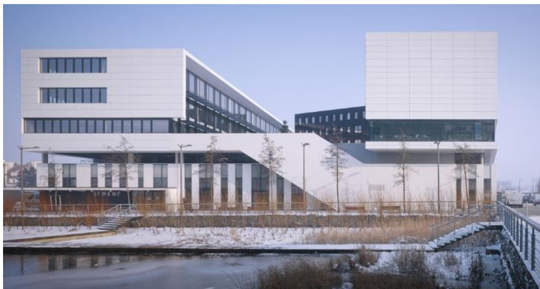
Рис. 2.8.1. Будівля Сервісного центру [13]
