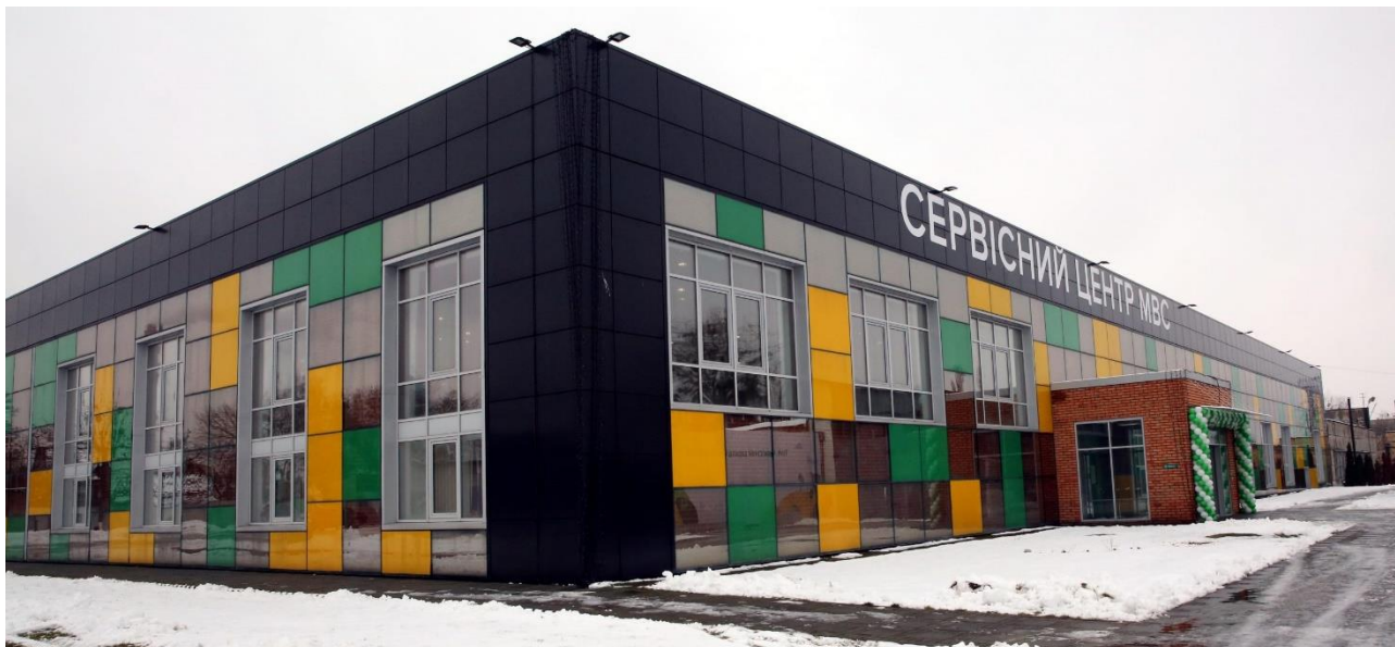
Рис. 2.1.1. Будівля Сервісного центру МВС в Україні (8041) в м. Київ, вул. Перемоги 20 [1]
