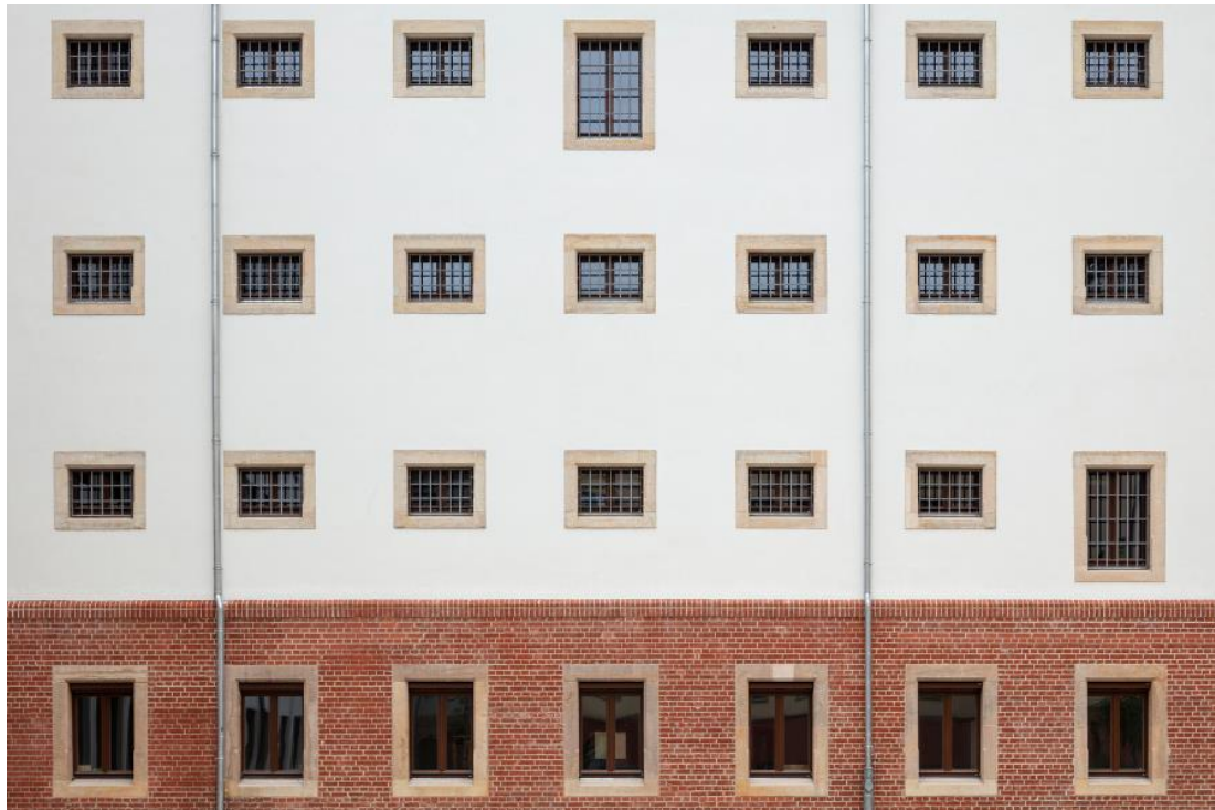
Рис. 2.7.4. Відреставрований фасад, що виходить на вулицю [12]
