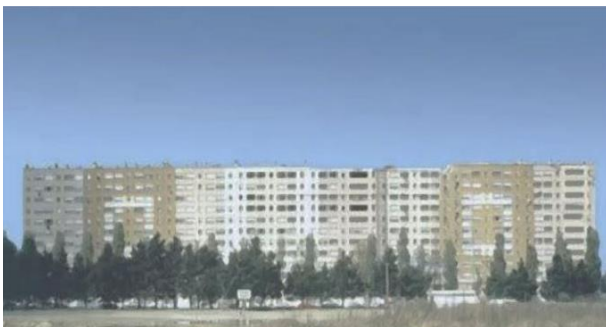
Рис. 1.3.17. Будівлі до реконструкції.
