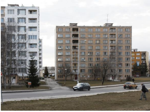
Рис. 1.3.1. Будівля до реконструкції.
