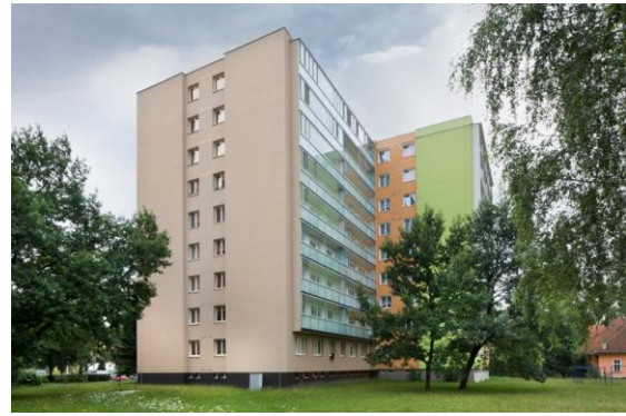
Рис. 1.3.4. Будівля після реконструкції.
