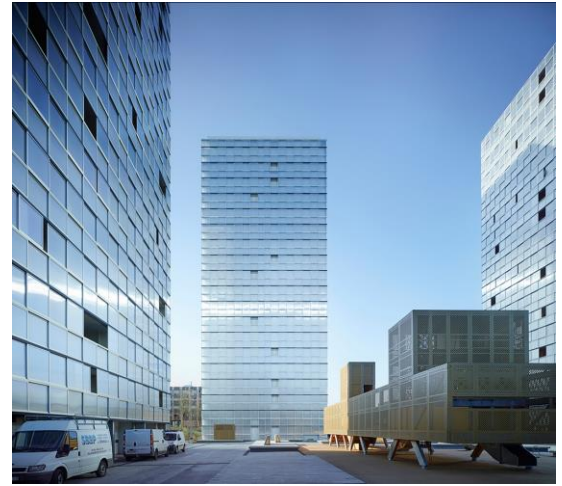
Рис. 1.3.14. Будівлі після реконструкції.
