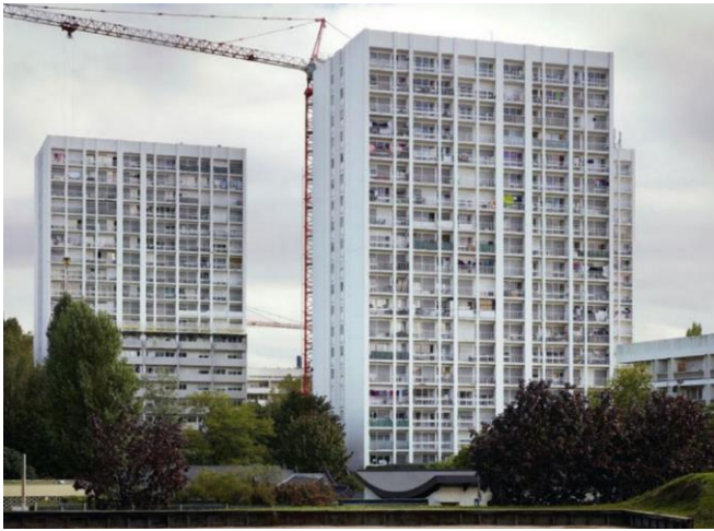
Рис. 1.3.13. Будівлі до реконструкції.
