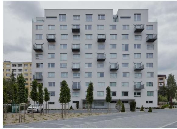
Рис.1.3.2. Будівля після реконструкції.
