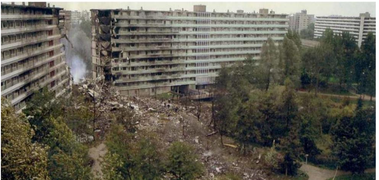
Рис. 1.3.21. Будівля після авіакатастрофи.
