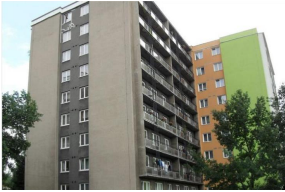
Рис. 1.3.3. Будівля до реконструкції.
