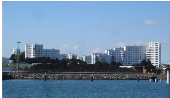
Рис. 1.3.18. Будівлі після реконструкції.
