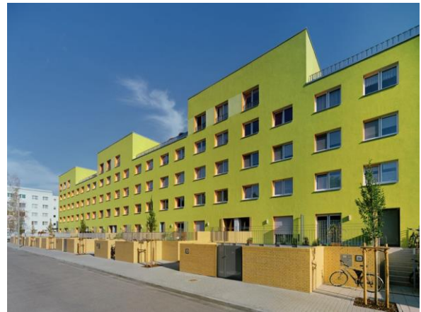
Рис 1.3.8. Будівля після реконструкції.
