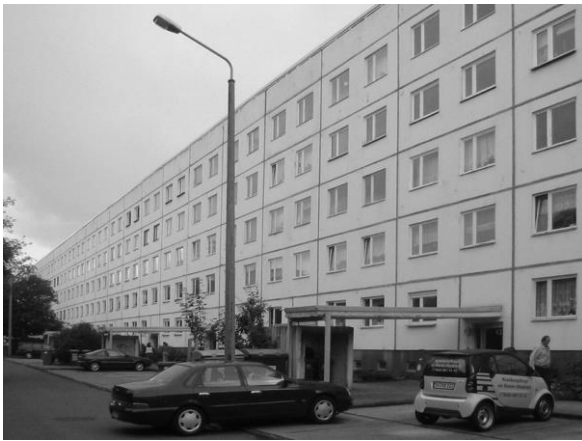
Рис. 1.3.7. Будівля до реконструкції.
