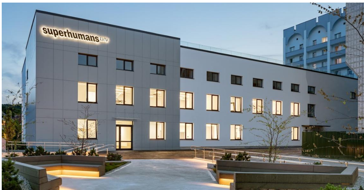
Рисунок 2.10 Загальний вигляд будівлі [3]
