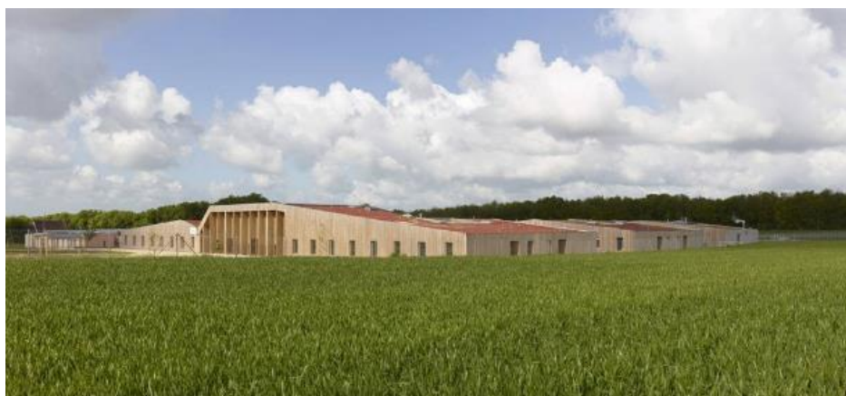
Рис.1.3.6. Фото медичного центру для людей з обмеженими можливостями, арх., Atelier Zündel Cristea, фото Stéphane Chalmeau, Лімей, Франція, 2011р. [65]
