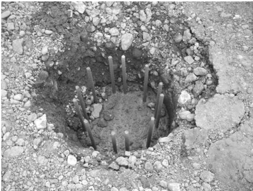
Рис. 3. Зовнішній вигляд свердловини, щойно заповненої бетоном
