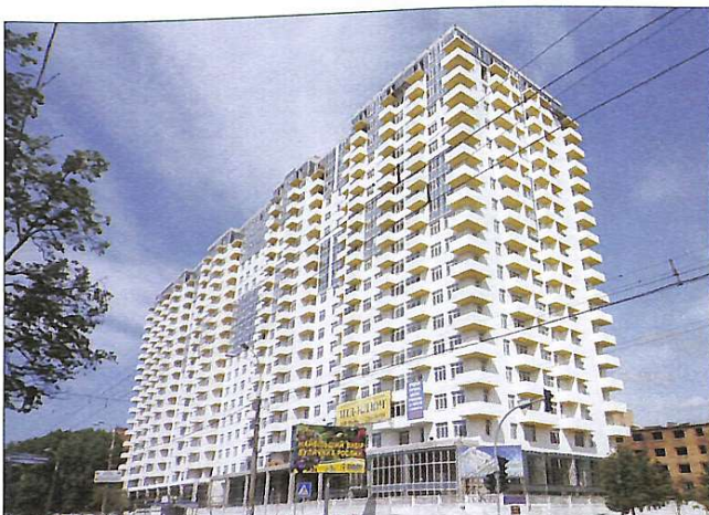
Енергоефективний пілотний проєкт розташований у Києві по вул. Щербакова, 52
