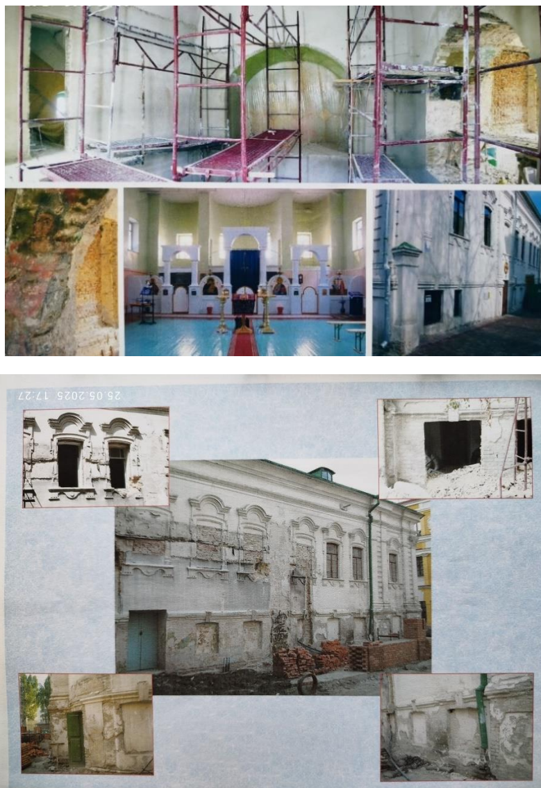
3.2.2. Загальна історична довідка. Вигляд до реконструкції
