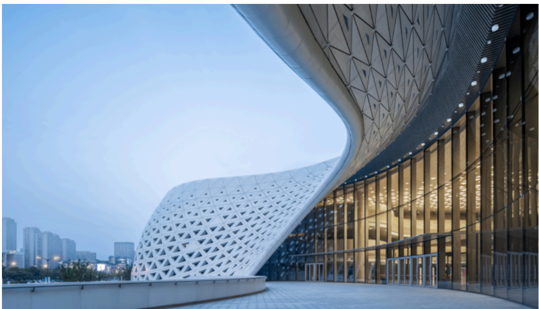
Рис. 2.40. Головний вхід до будівлі [50].
