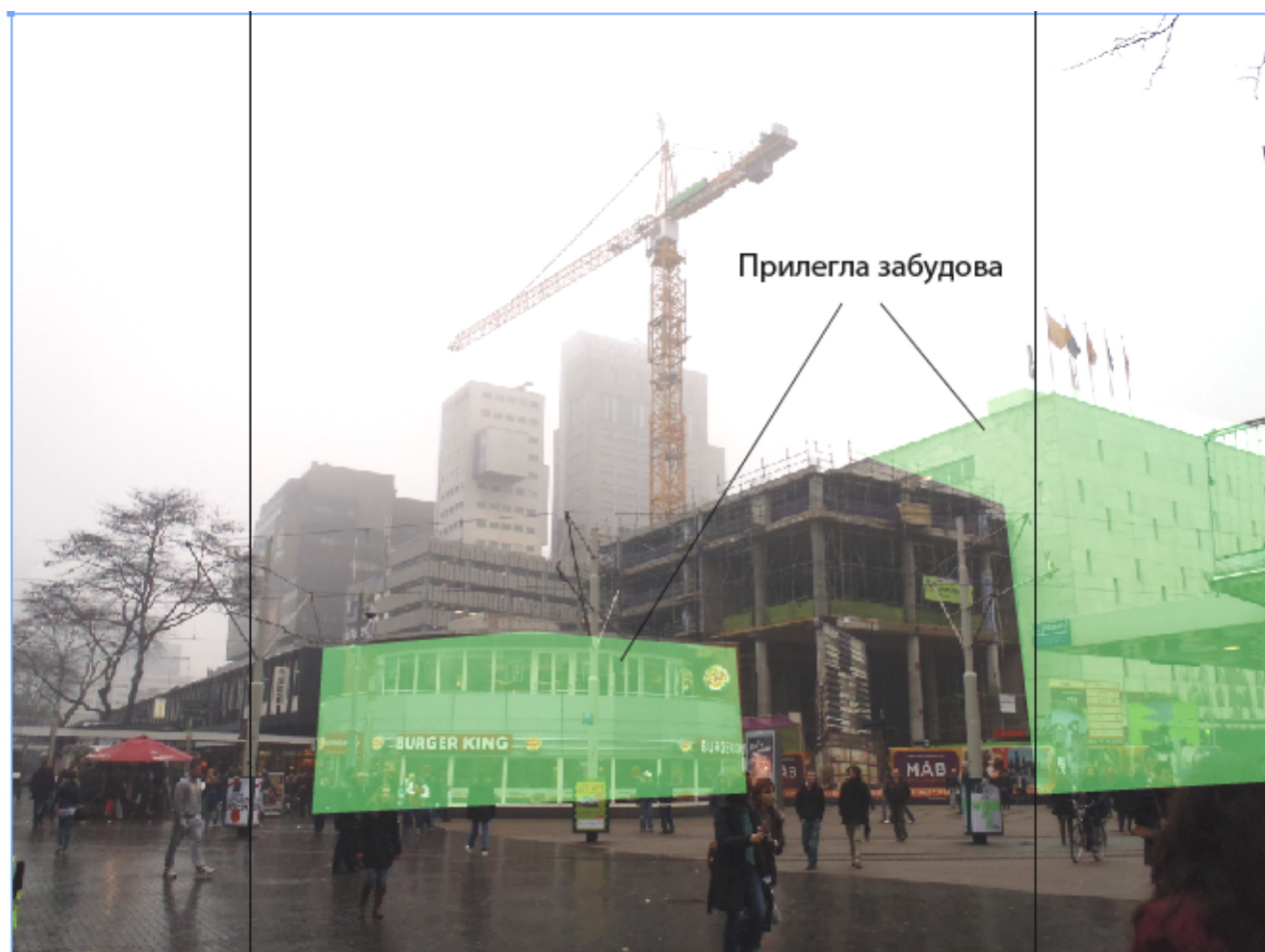
Рис. 5. Спорудження двадцятиповерхового житлового комплексу з приміщеннями торгівельної сфери The V-Tower. Роттердам, Нідерланди. 2009-2011 р
