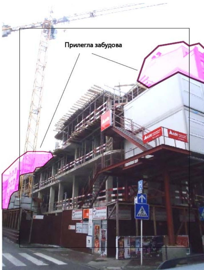
Рис.3. Спорудження шести-поверхового житлового будинку. Люксембург, 2009-2010 р
