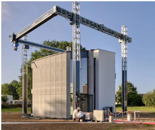
Рисунок 2. Технологія 3-D друку за допомогою портального робота
