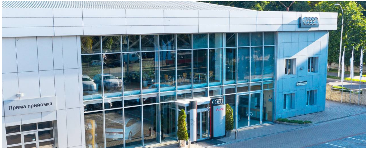
Рис.2.3 Фото фасаду автосалона ВІПОС Ауді
