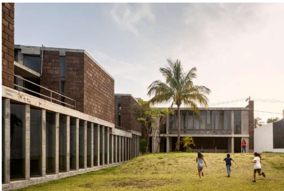
Рис 2.10 Загальний вигляд будівлі
