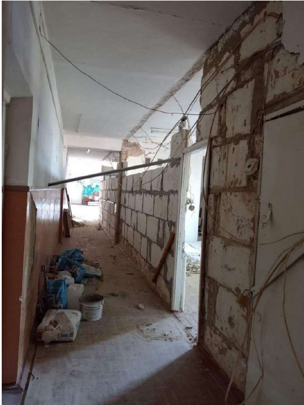
Рис.3.1.2. Встановлення нових перегородок в класах.
