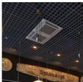
Рис 2.18. Касетний кондиціонер
