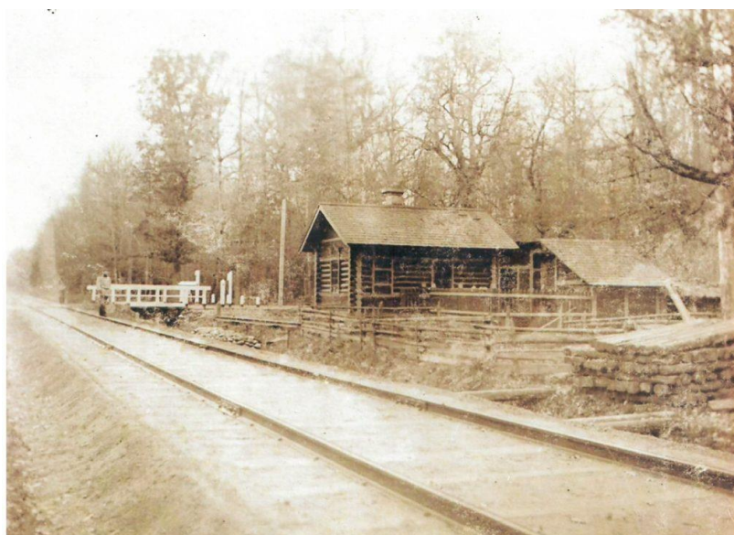
Рис. 2.11. Будівництво станції Буча
