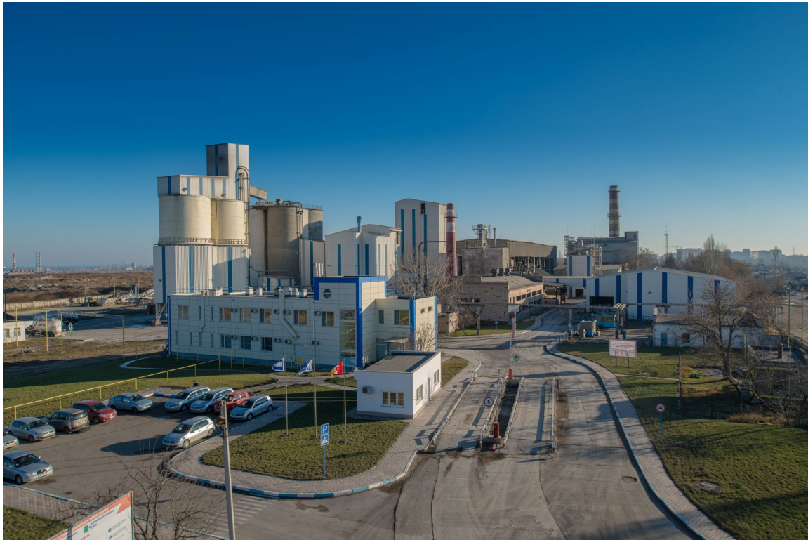
Рис. 2.1. Одеський цементний завод
