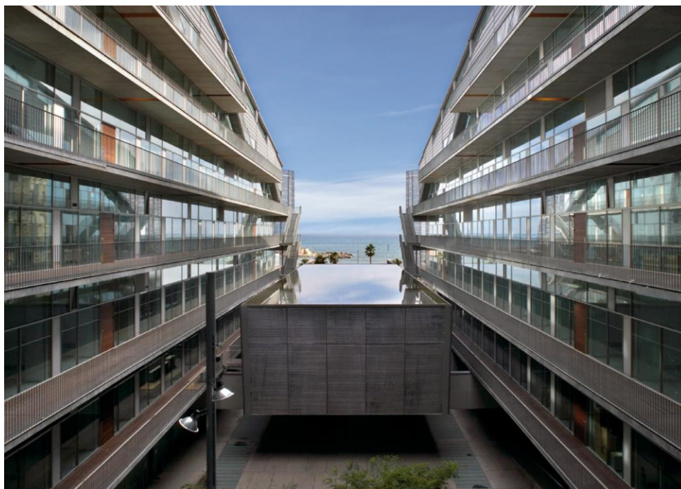
Рис.3.2 Вид з будівлі ДЦ
