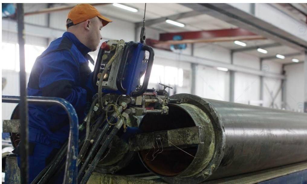
Рис.23. Заливка труби термокомпонентною сумішшю ППУ.
