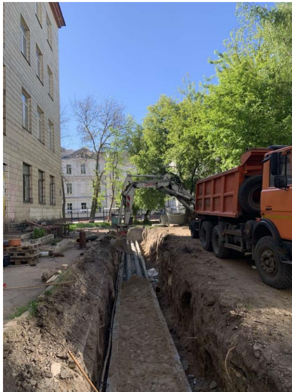
Рис.28. Засипка піском.
