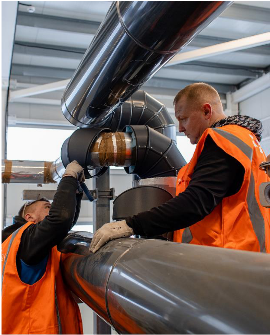
Рис.24. Монтаж кожуха на сталеву провідну трубу.
