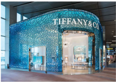
Бутік TIFFANY. Архітектори MVRDV.
