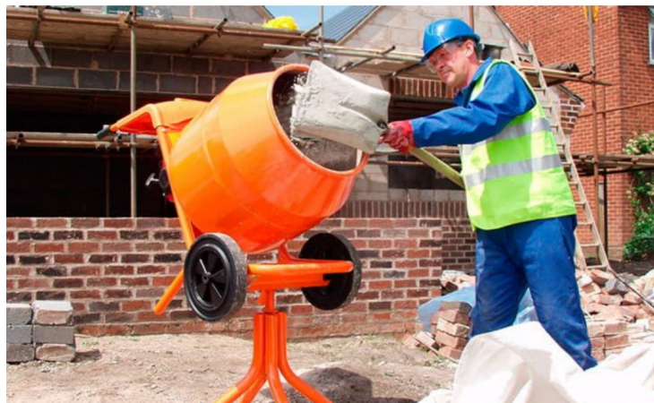
Рис.1.8. Процес приготування бетону
