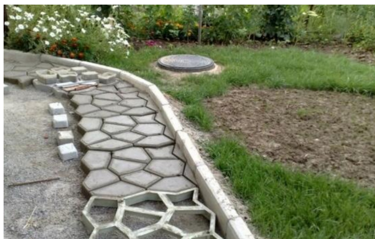
Рис.1.4. Доріжка з декоративного бетону
