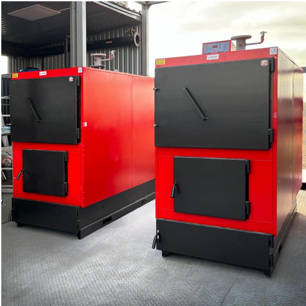
Рис. 4.4 Твердопаливні котли KORDINAMIK тепловою потужністю по 523 кВт кожен з ручним завантаженням палива
