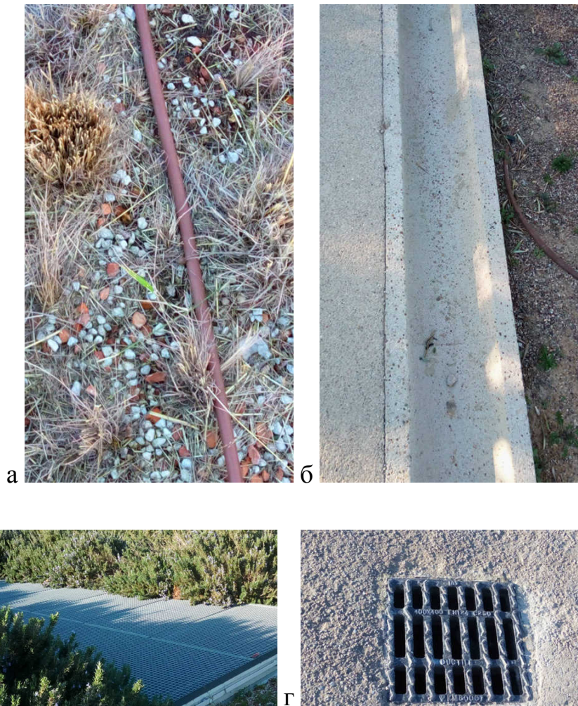
Рис. 8.23. Система накопичення дощових стічних вод зеленою покрівлею (авторські світлини): а – рослинний шар з ґрунтом і краплинним поливанням; б – водозбірний лоток; в – резервуари для збереження води; г – зливоприймач
