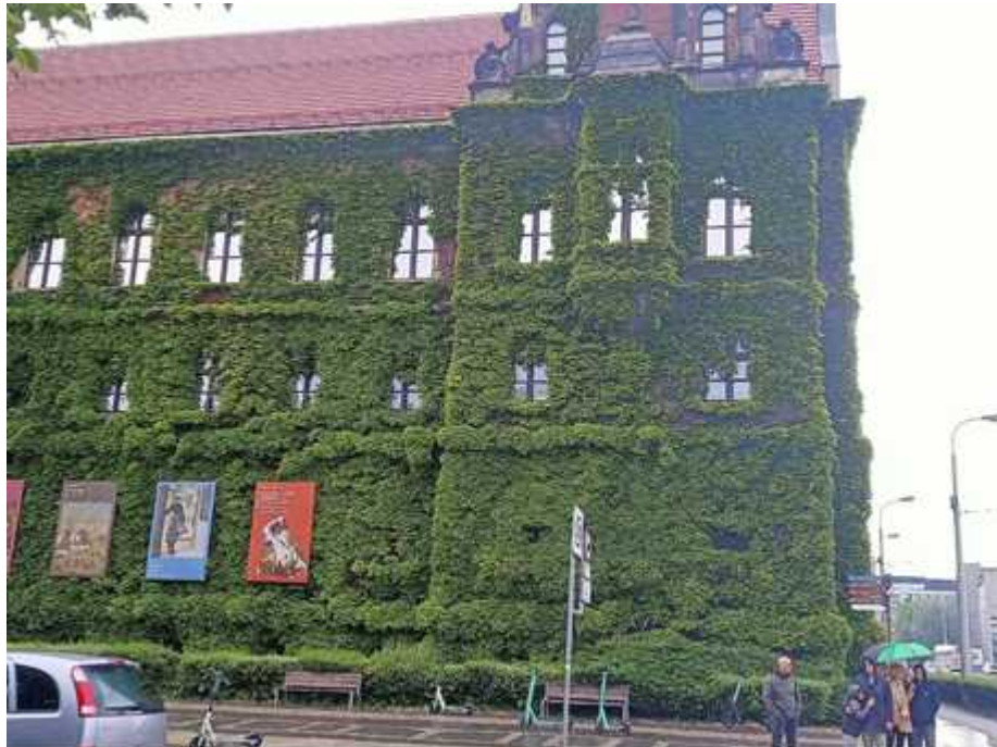
Рис. 4.17. Вертикальне озеленення фасаду будівлі Національного музею, м.Вроцлав, Польща (авторська світлина)
