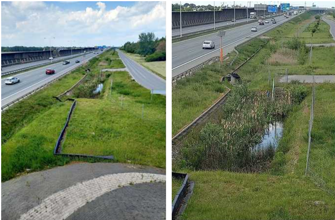
Рис. 3.4. Відведення надлишку дощових стічних вод з ланів та автошляхів за допомогою технологій зелених конструкцій – дощових садів. М.Вроцлав, Польща (авторські світлини)
