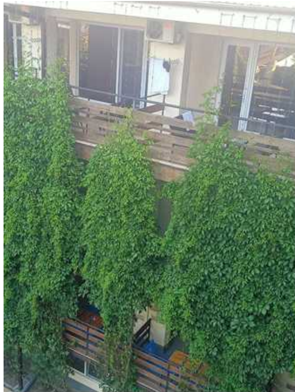
Рис. 4.15. Вертикальне озеленення фасадів будівлі готельного комплексу Казка, селище Кароліно-Бугаз, Одеська область (авторська сітлина)
