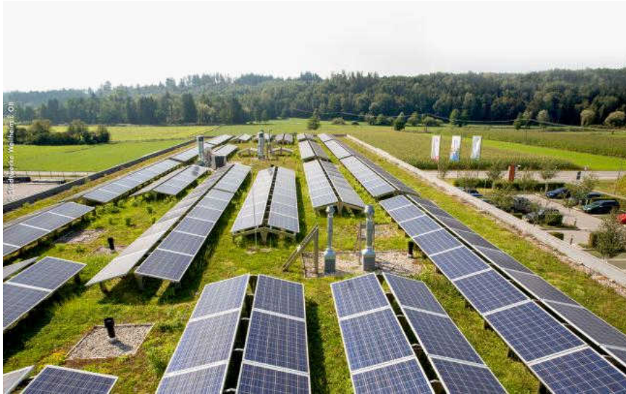
Рис. 8.18. Зелені покрівлі з фотовольтаїчними панелями [4]
