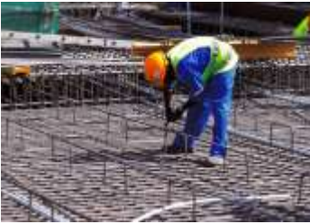
Рисунок 2. Процес в'язання арматурних сіток і каркасів
