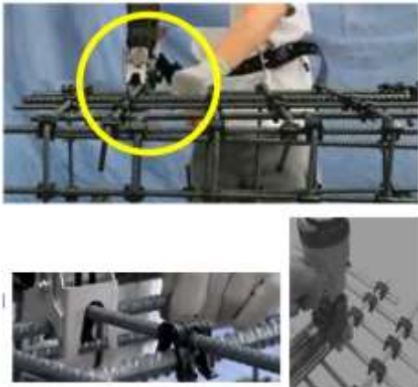
Рисунок 3. Елементи технології чотириточкового автоматичного зчеплення арматури без стяжного дроту «КОДІ КЛІП»
