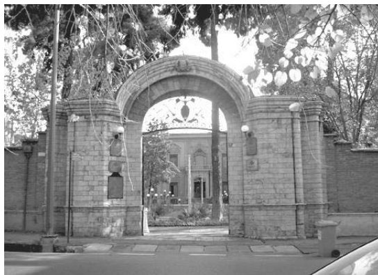
Рис.7. Фасад европейского входа дома Кавама ас-Салтане, расположенного в конце улицы округа Доулат.
