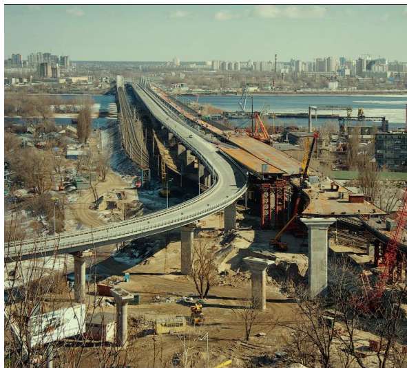
Рис. 3.1.11 Фото будівництва нового Дарницького мосту, 2004 р. [51]
