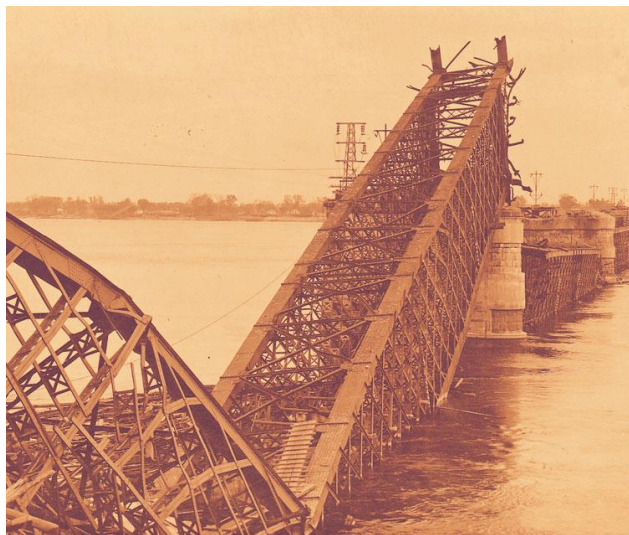
Рис. 3.1.10 Фото мосту Струве після підриву німцями, 1943 р. [51]
