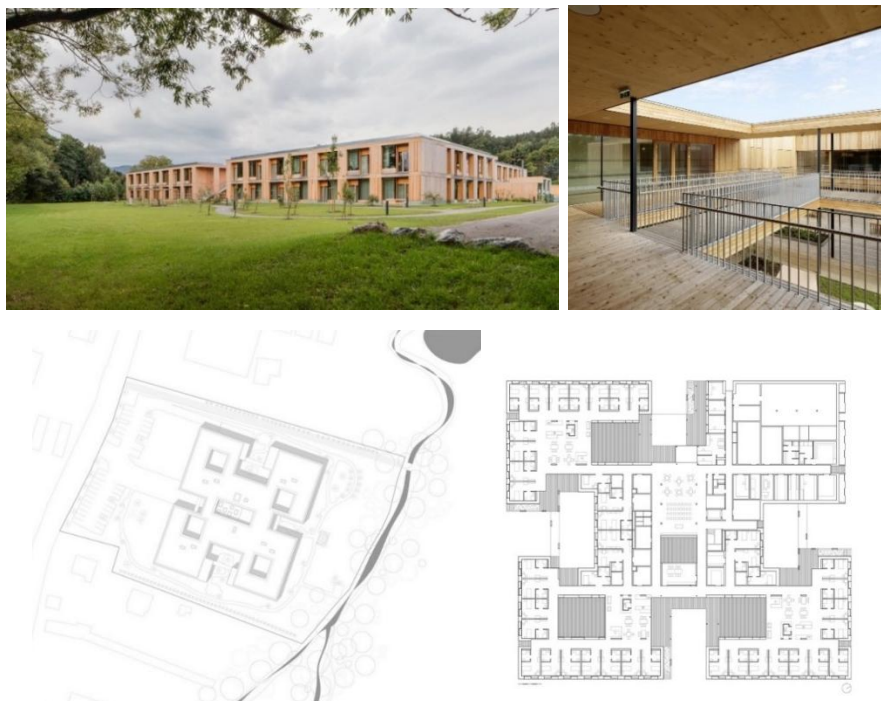
Рис. 1.3.21. Будинок догляду Residential Care Home Andritz. Архітектори: Dietger Wissounig Architekten. Рік: 2015, м. Грац, Австрія [54]
