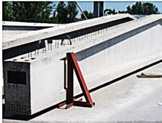
Рис. 14. Кондуктор для закріплення балки при складуванні.
