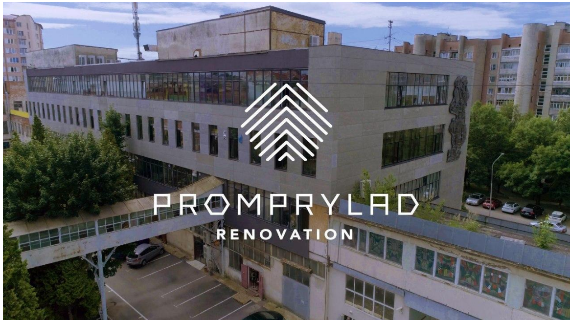
Рис. 1.16 Айдентика та будівля колишнього заводу «Промприлад» у м. Івано-Франківськ
